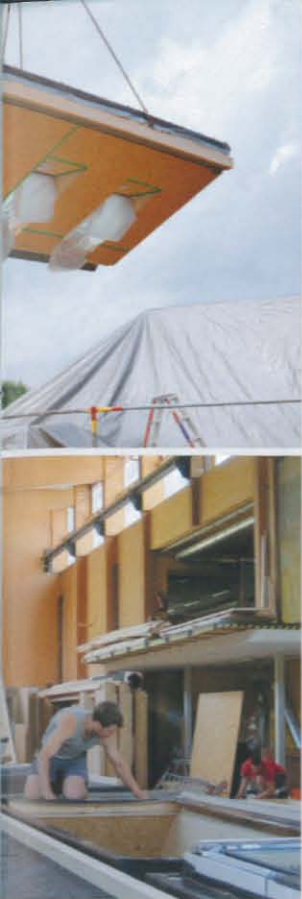
7 1-6 Das Sunlighthouse wurde nach den Plänen von Hein-Troy Architekten im Zimmereibetrieb mittels CAD bis ins kleinste Detail geplant und fast vollständig vorgefertigt. So konnte die Errichtung des Hauses binnen fünf Tagen abgeschlossen werden. Weitere fünf Tage wird die Verschalung in Anspruch nehmen. 7 Zur Zeit wird am Sunlighthouse noch gearbeitet. Ein Rendering zeigt, wie es aussehen wird. Eröffnet wird Ende Oktober 2010.
