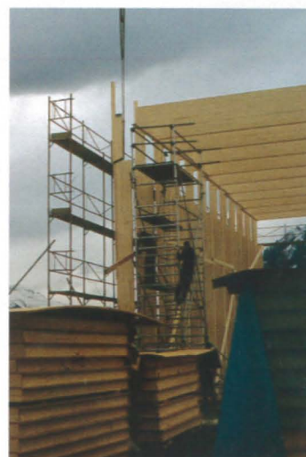
Abb. 8.11.03 Montage der Primärkonstruktion
