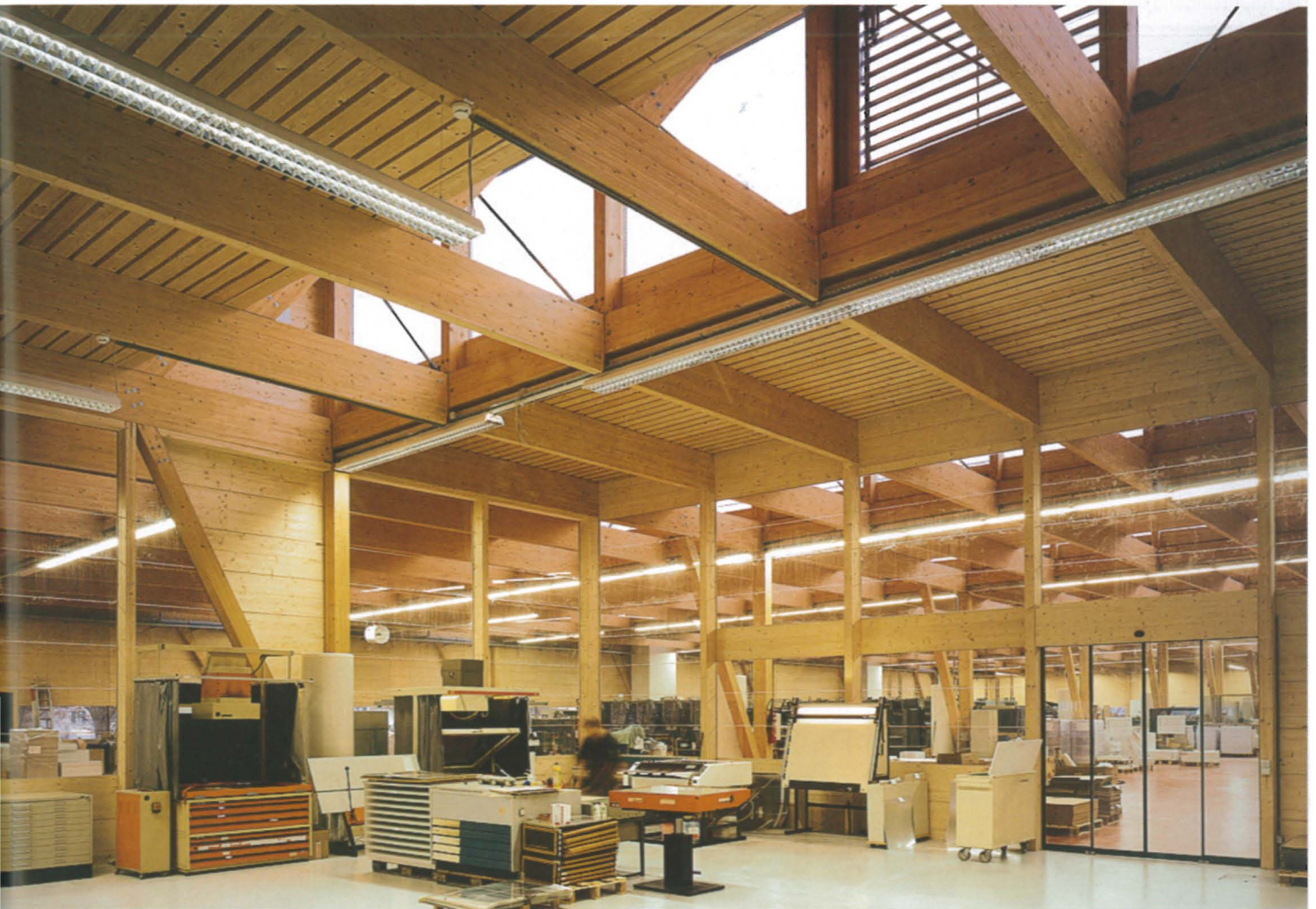
Abb. 8.12.02 Wesentliche Bereiche der Druckerei werden von Fachwerkträgern aus BS-Holz überspannt
