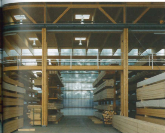
8.1.08 Mittlere Stützenreihe gliedert die Halle in zwei Joche
