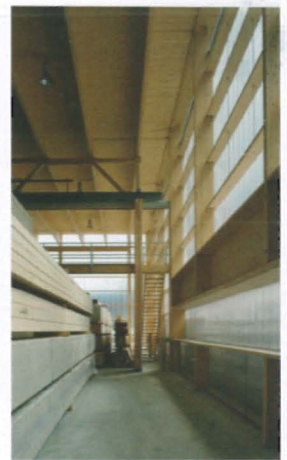
Abb. 8.1.10 Westseite der Halle
