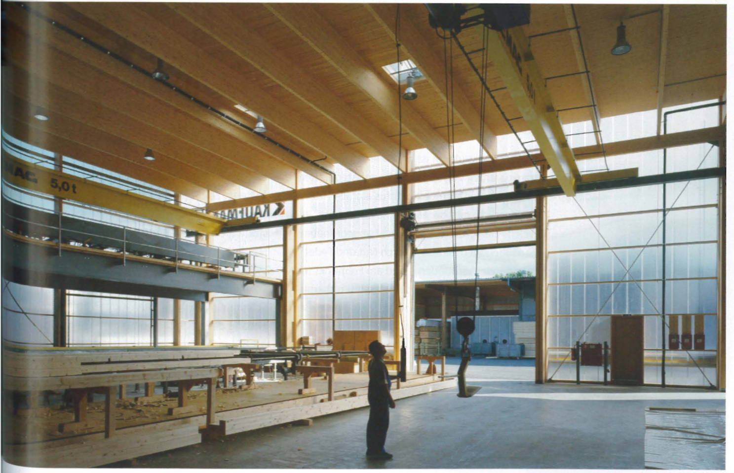
Abb. 8.1.04 BS-Holz-Träger im Abstand von 2 m sorgen für eine ruhige und klare Untersicht der Decke
