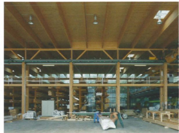
Abb. 8.1.09 Die Hallendecke ist größtenteils mit einer Brettschalung belegt
