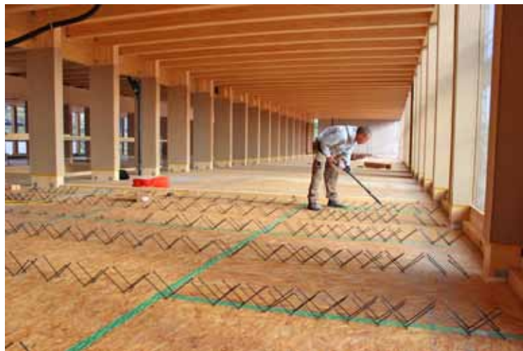
Holz-Beton-Verbunddecke als Balkendecke. Die OSB-Platte dient als verlorene Schalung zwischen den Balken. Der Verbund wird über schräg eingedrehte Schrauben hergestellt
