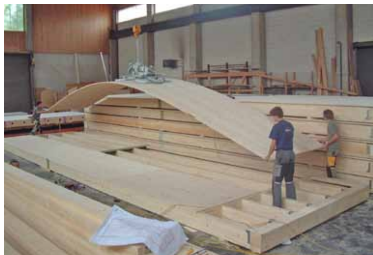
Bei der Holzrahmenbauweise werden die Rohmaterialien in die Zimmerei geliefert, dort abgebunden, zu Elementen vorgefertigt und dann auf die Baustelle transportiert
