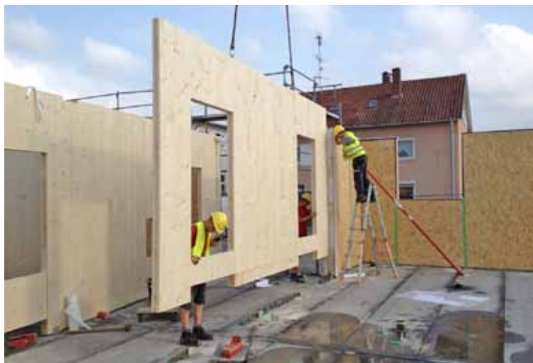
Brettsperrholzplatten werden meist schon beim Hersteller konfektioniert, direkt auf die Baustelle transportiert und dann montiert
