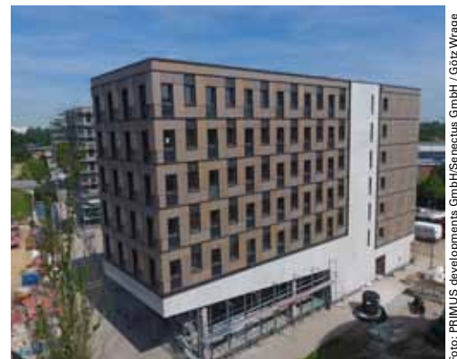
„WOODIE“: eine hybride Bauweise mit Sockel und Erschließungskernen aus Stahlbeton
