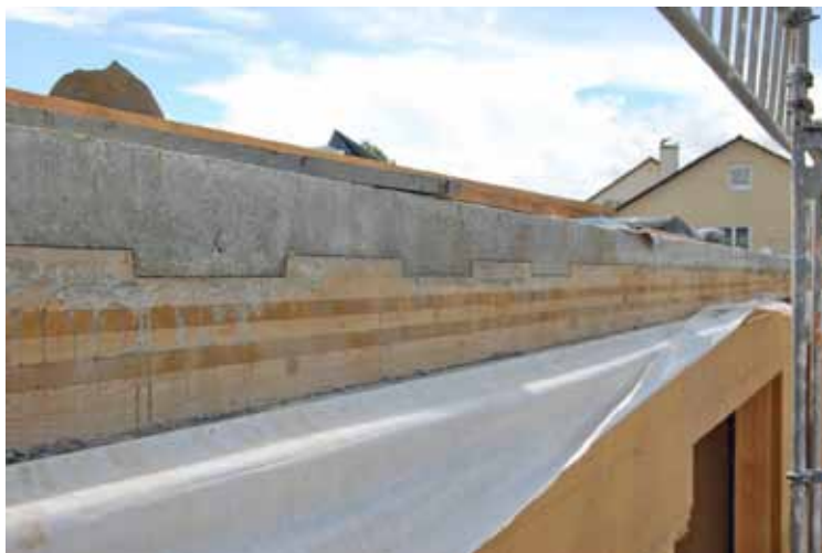
Holz-Beton-Verbunddecke als Flachdecke. Der Verbund erfolgt über die Kerne im Holz und den Nocken im Beton und somit über geometrischen Formschluss
