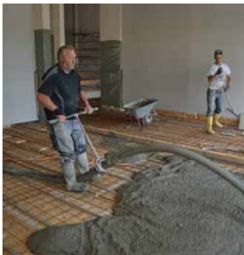
Einbringen von Ortbeton auf eine Balkendecke mit OSB als verlorene Schalung. Oft wird der Holzbau bis Dachkonstruktion fertiggestellt und der Beton am Schluss eingepumpt
