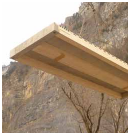
Vorgefertigte Holz-Beton-Verbunddecke als Balkendecke. Die Herstellung erfordert einen speziellen Schalkörper
