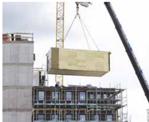
Vorgefertigte Raummodule aus Holz bei dem Gebäude „WOODIE“ (Projektbericht S.30)
