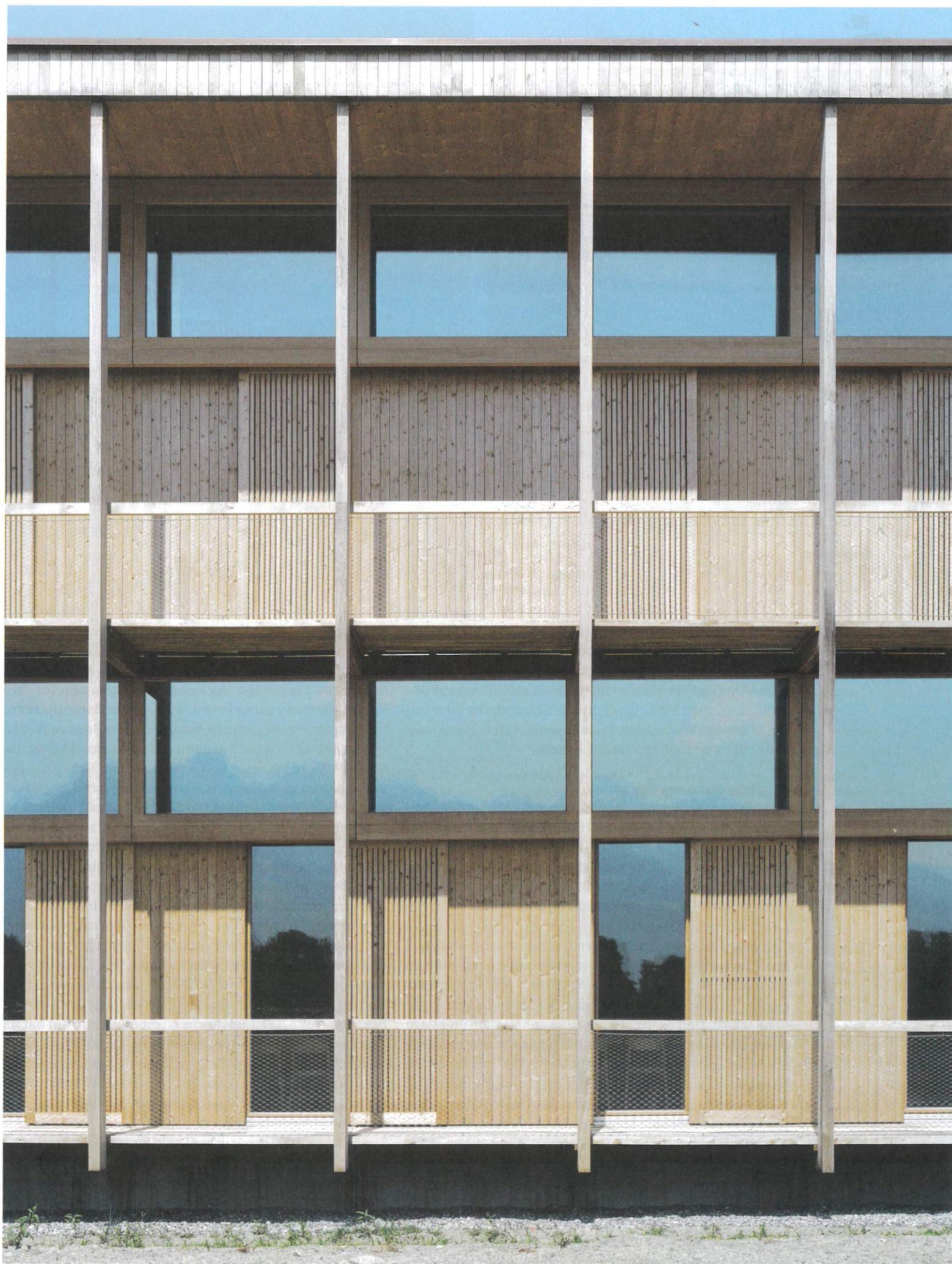
Das Landwirtschaftliche Zentrum in Salez setzt auf natürliche Lösungen: Laubengänge und Schiebeläden beschatten die Fenster.
