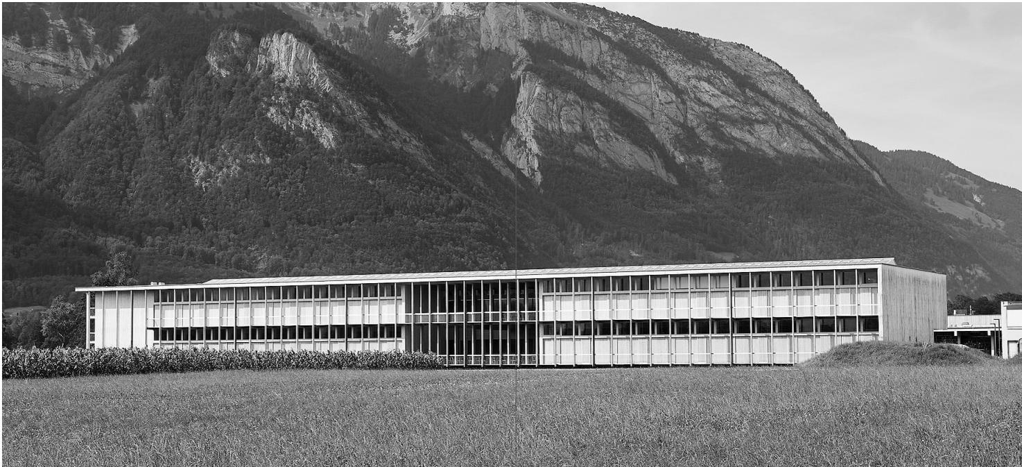
Das L-förmige Gebäude steht auf einer Pfahlgründung mit Rammpfählen aus Stahlbeton-Fertigteilen. Das Untergeschoss und die Bodenplatte bestehen aus Stahlbeton, der als thermische Speichermasse dient. Die Tragstruktur der Obergeschosse ist mit Ausnahme der Holz-Beton-Verbund-Decken eine reine Holzkonstruktion, die auch
