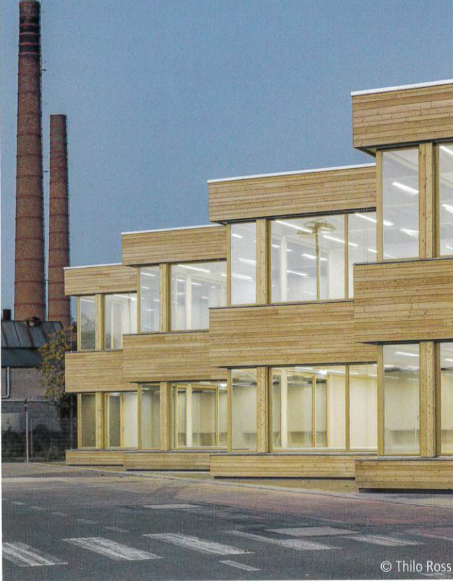
Abb. 2: Die gegliederte Rasterstruktur aus geometrischen Vor- und Rücksprüngen mit großzügigen Verglasungen bietet Raum für den Aufbau von Verbindungen zum Altbestand
