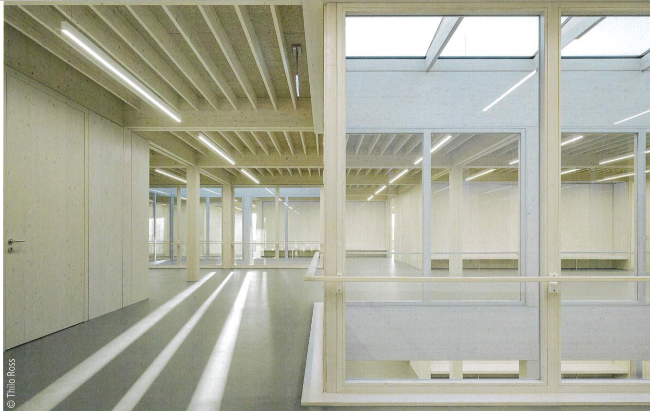
Abb. 4: Der vollumfängliche Einsatz des nachwachsenden Baustoffs Holz prägt den Gewerbebau mit dem sichtbaren Tragwerk und den Raumumgebungsflächen auch im Innenbereich
