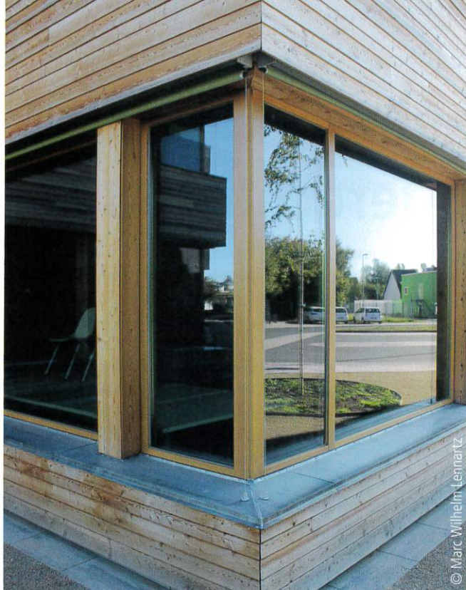
Abb. 5: Mit der hinterlüfteten und witterungsresistenten Lärchenholzfassade zeigt sich der Holzbau auch im Außenbereich
