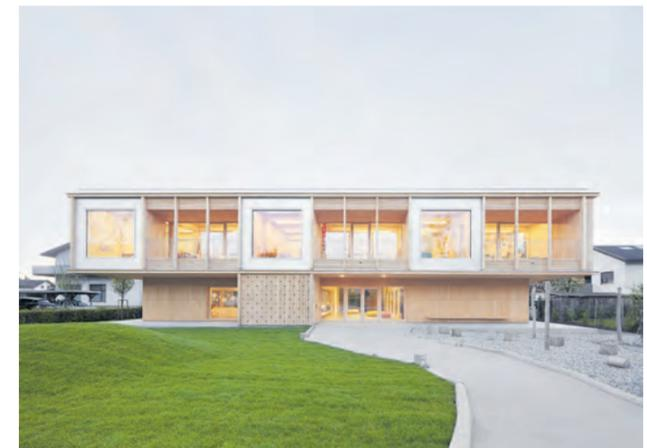
**RHYTHMISIERUNG** Einzüge rhythmisieren das Erdgeschoß, bieten überdachte Wege und lassen die Struktur aus aussteifenden Kernwänden stehen.
