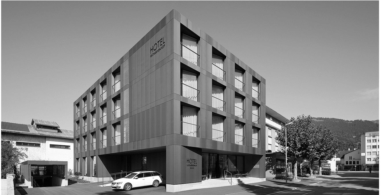
An das bestehende Hotel Katharinenhof wurde ein viergeschossiger Kubus in Holzmodulbauweise angebaut. Hoher Vorfertigungsgrad mit präziser Fertigung der insgesamt 39 Zimmereinheiten ermöglichte eine enorm kurze Bauzeit. Durch das Ausdrehen der einzelnen Fensterelemente erhält jedes Zimmer einen kleinen Außenbereich, welcher von den Gästen als Balkon benutzt werden kann. Die Zugangsbereiche im Erdgeschoss sind durch Einschnitte in den Kubus definiert. Als Fassade wurden Metallplatten verwendet.
