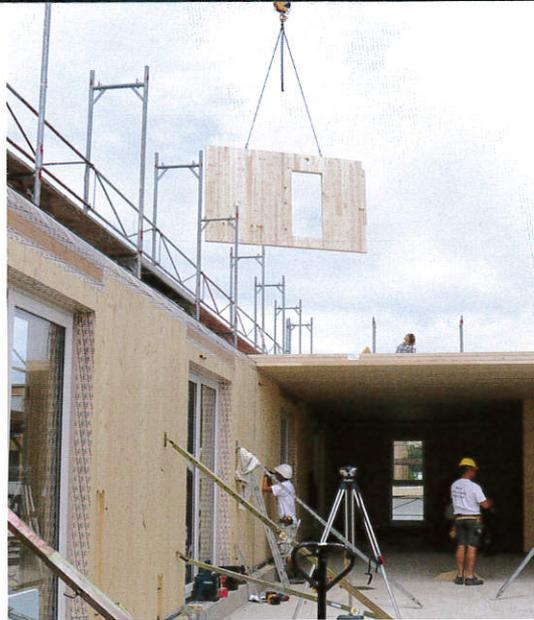
Dank des hohen Verfertigungsgrades konnten die insgesamt sechs Geschosse eines Baukörpers in nur 30 Tagen errichtet werden.
