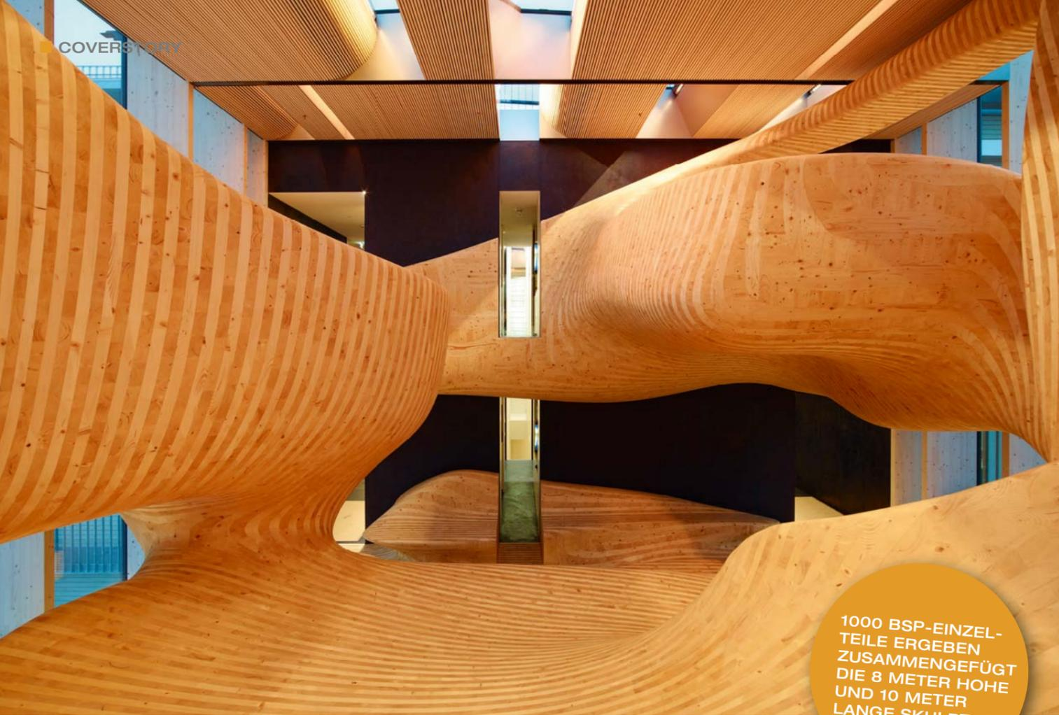
1000 BSP-EINZELTEILE ERGEBEN ZUSAMMENGEFÜGT DIE 8 METER HOHE UND 10 METER LANGE SKULPTUR
