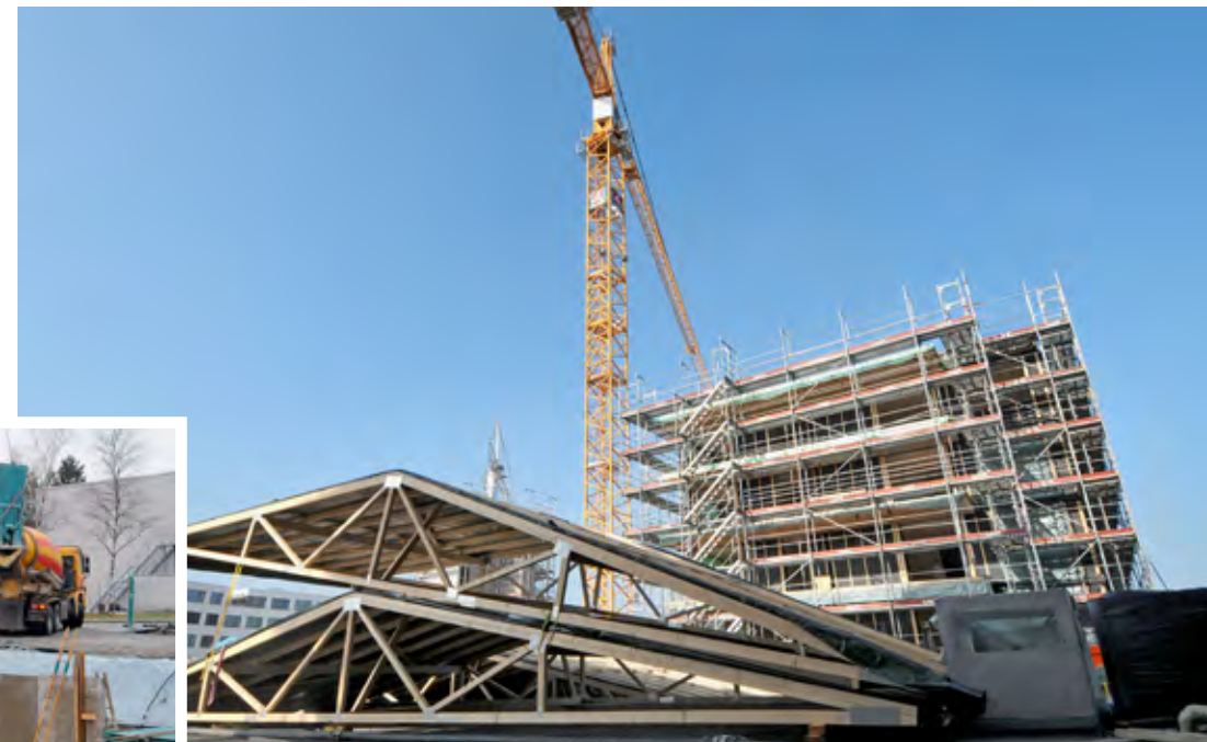
Grosse Notdächer dienen den frisch aufgerichteten Holzbauten als Schutz vor den häufigen Regengüssen (oben). Die Einstellhalle für 400 Autos wurde abschnittsweise betonierte (links).
