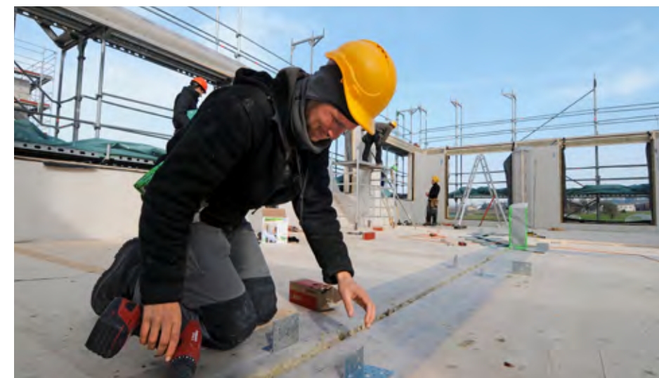
Vier Wochen benötigten die Holzbauer der Arge Fussenegger-Zaugg für das Aufrichten des ersten Gebäudes. Inzwischen haben sie den Takt auf drei Wochen gedrückt.
