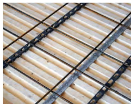
Die Häuser der Arge Hecht-Tschopp-Bisang werden mit Holz-Beton-Verbunddecken gebaut. Unmittelbar auf die Deckenelemente (oben) wird die Bewehrung aufgebracht (rechts).
