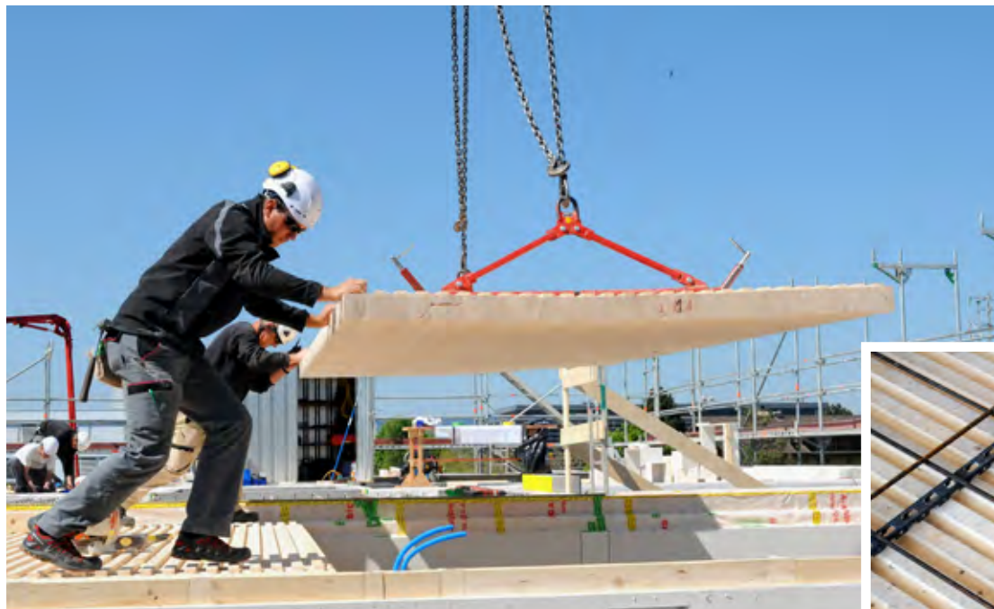
Die Häuser der Arge Hecht-Tschopp-Bisang werden mit Holz-Beton-Verbunddecken gebaut. Unmittelbar auf die Deckenelemente (oben) wird die Bewehrung aufgebracht (rechts).
