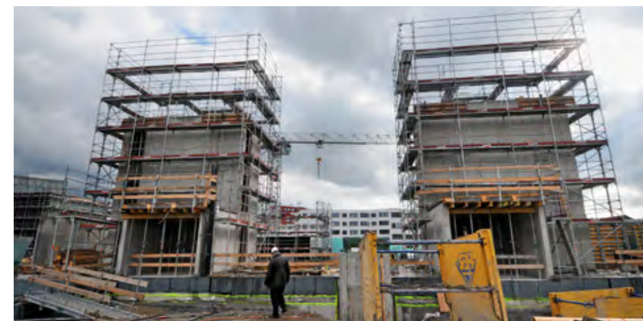
Über massive Stahlverbindungen werden die Lasten der Häuser 5–9 in die tragenden Betonkerne eingeleitet. Die Geschosse entstehen in der «österreichischen» Plattenbauweise.
