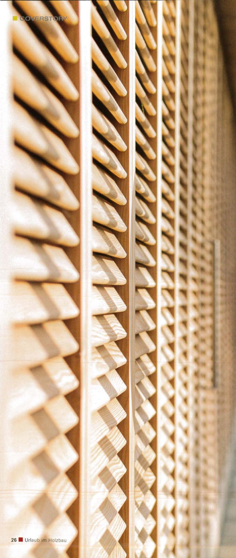
Erinnert an Fensterläden: Die Außenhüllen der Raumkörper bestehen aus einer filterartigen Schicht aus Lamellenladenelementen unterschiedlicher Ausführung und sind lichtdurchlässig. Für das gesamte Gebäude kam Weißtannenholz aus der Region zum Einsatz.
