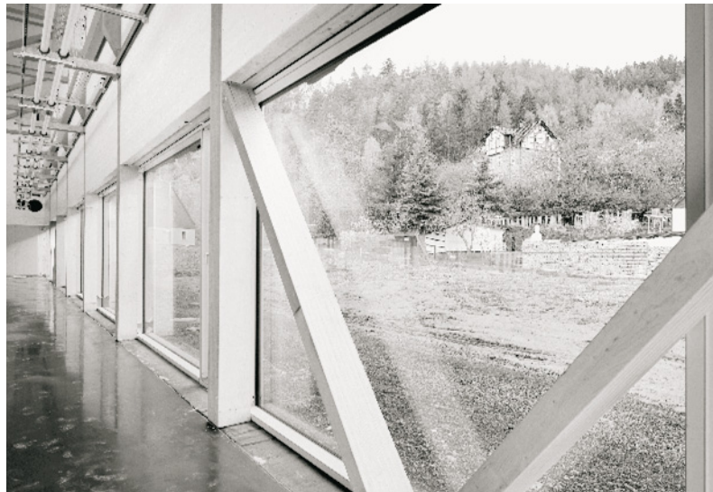
Um Flecken an der Oberfläche zu vermeiden, wurden bei diesem Projekt alle Träger mit einem Schutzanstrich versehen.
