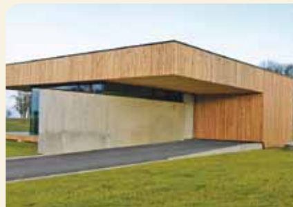
Foto: Architekturbüro Arkade ZT GmbH
