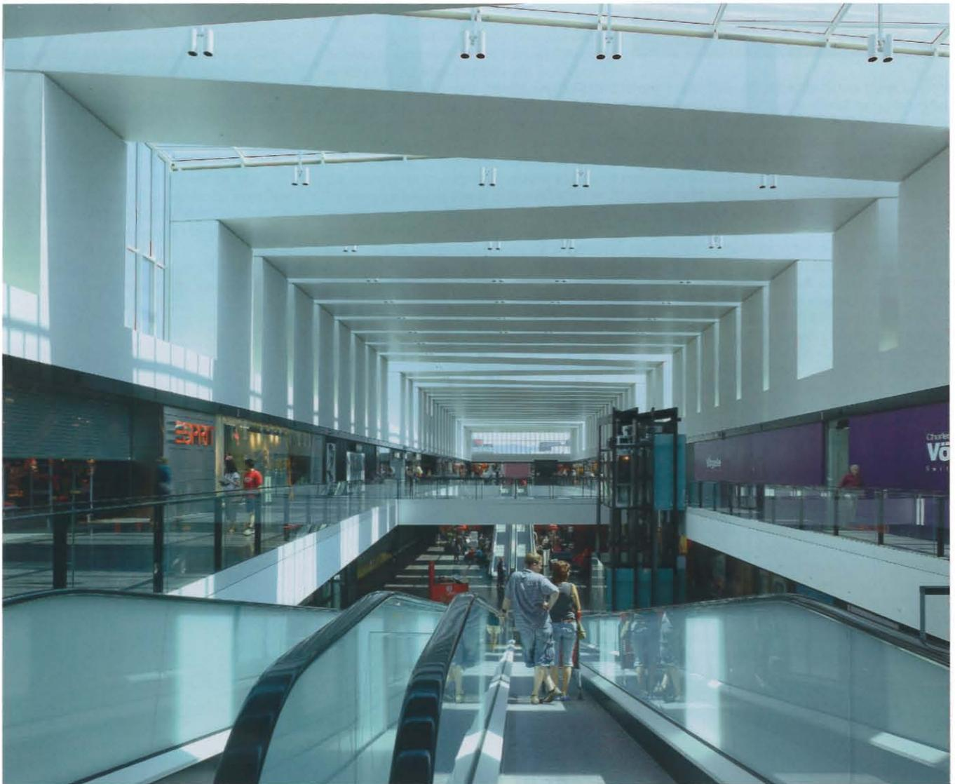
Die Haupthalle ist das Herz des neuen Einkaufszentrums (Marin Centre) in La Tène. Das Dach mit seinen unregelmässigen Öffnungen besteht aus 38 vorgefertigten Rahmen in Holz.
