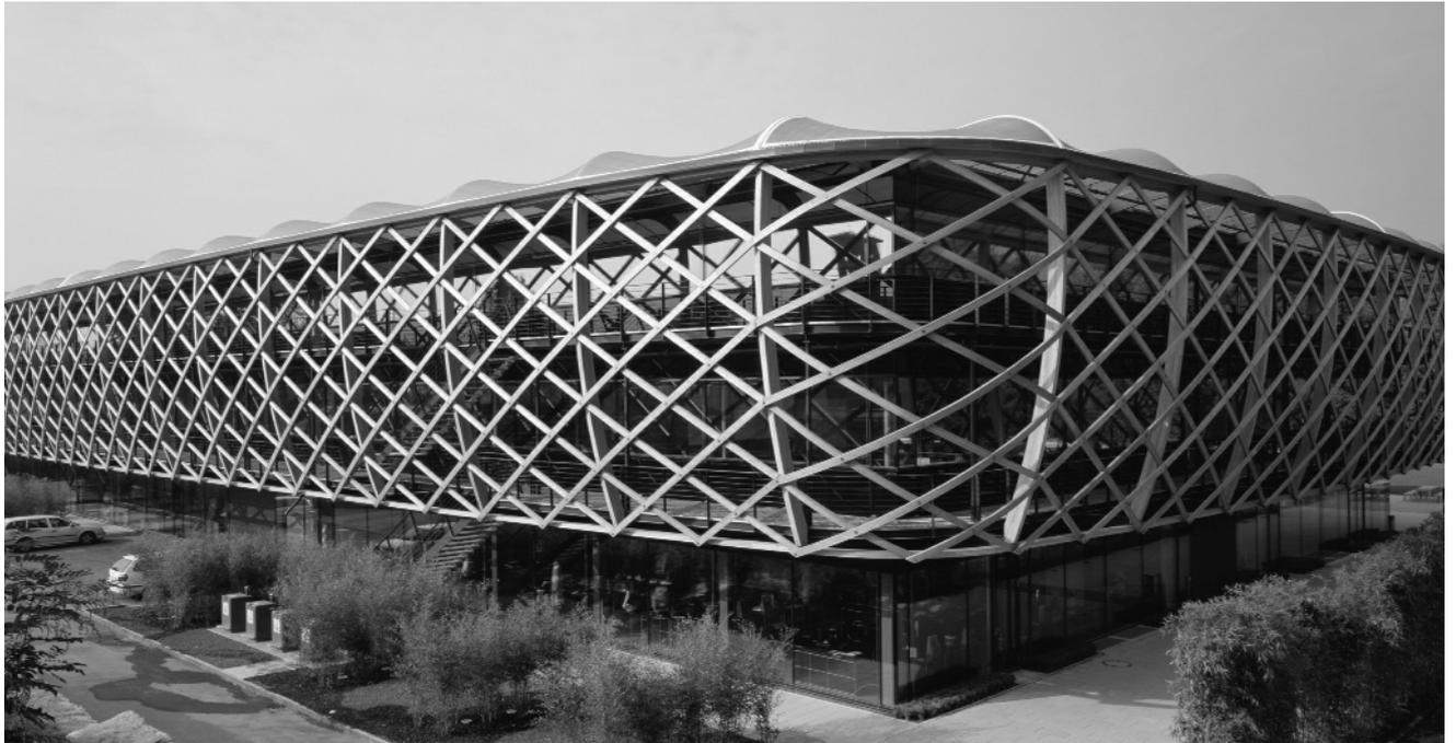
Mitten im Grün eines Tessiner Seitentals liegt das neue Kompetenzzentrum von Hugo Boss. Der Bau für Verwaltung und Entwicklung ist ein Hybridbauwerk aus Stahl, Holz und Beton, ummantelt mit einem rautenförmigen Holzkorbgeflecht. Das tragende Stahlskelett ist mit Brettstapeldecken ausgefacht, darüber wurde ein aussteifender Ortbetonbelag gelegt. Dadurch konnten Großraumbüros mit Abmessungen von 14 x 80 Meter geschaffen werden.
