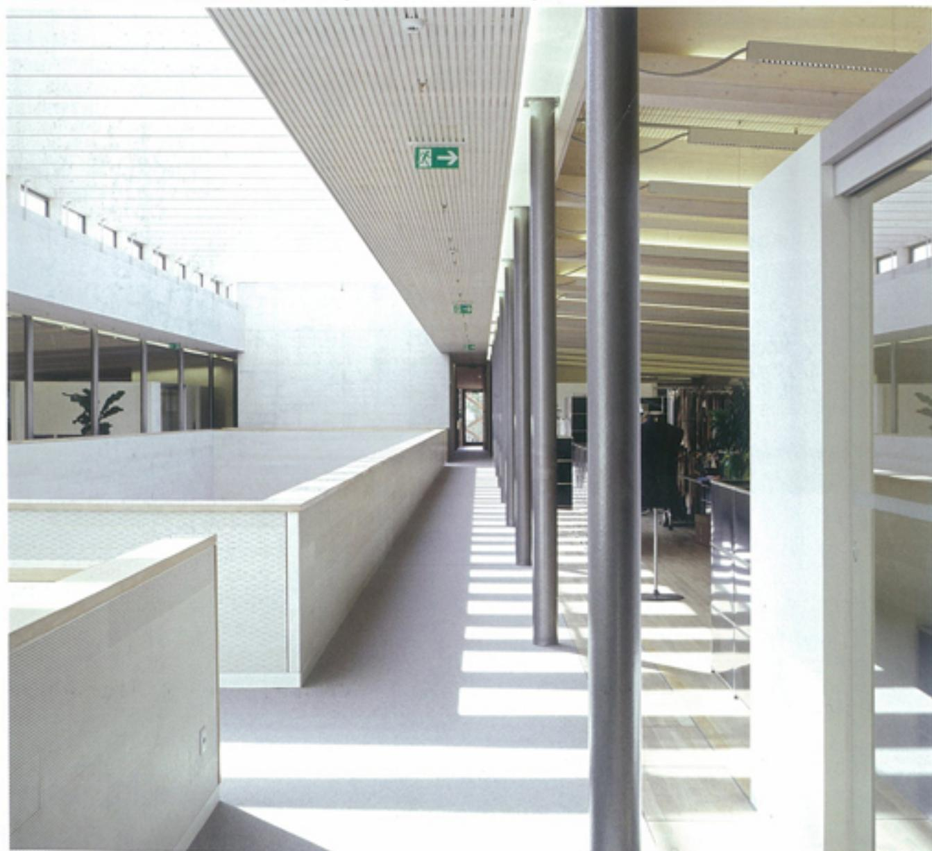
Perforierte Holzpaneele sind kleidsam und dienen als schallschluckende Elemente. Perforated wood panels are attractive and serve as sound-absorbing elements.
