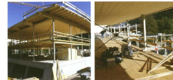
Die Stahlstützen leiten als tragende Elemente alle Lasten in den Stahlbetonsockel ab. Die Wände aus Holzelementen dienen als Raumabschluss und Aussteifung.
