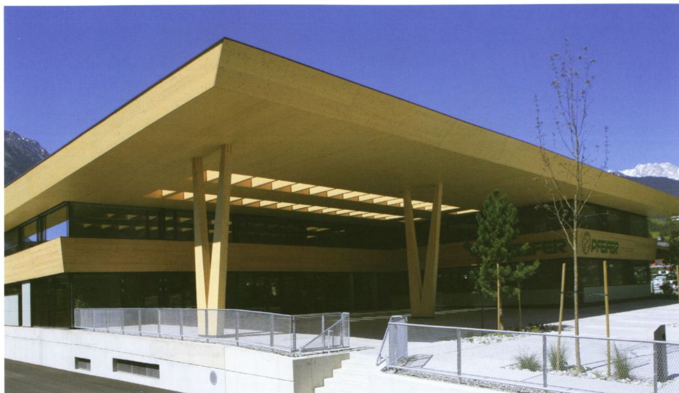
Die beiden oberen Geschosse sind in Holz-Stahlbauweise auf einem Geschoss in Stahlbeton errichtet, das dem Gebäude festen Untergrund bei Hochwasser bietet.
