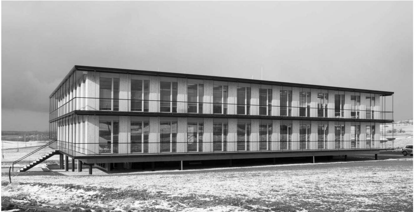
Die Bürozentrale dieses holzverarbeitenden Betriebes, der in Österreich, der Schweiz und Deutschland präsent ist, zeigt eine neuartige, extrem wirtschaftliche und flexible Konstruktion mit Fichten-Brettschichtholz aus eigener Produktion. Die Architektur wurde so konzipiert, dass einerseits ein Minimum unterschiedlicher Bauelemente, andererseits ein Optimum an Massivholzteilen eingesetzt wurde. Zielvorstellung war ein sehr "einfaches" Gebäude mit wenigen Schichten in der Außenwand.
