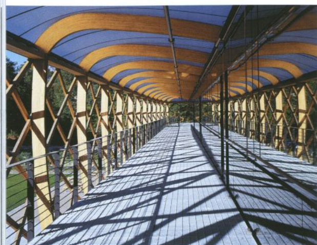
Zwischen der Holzstruktur und der Glasfassade laufen Fluchtbalkone rings ums Gebäude. Der Dachbereich ist hier mit transluzenten Membranen gedeckt.
