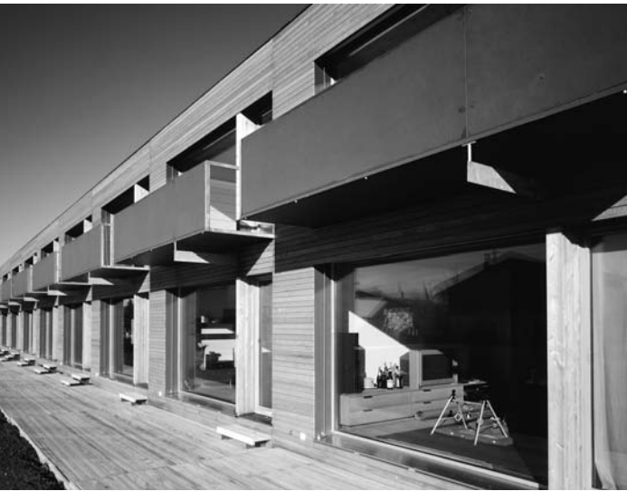
Passivreihenhausanlage Falkenweg, Dornbirn
