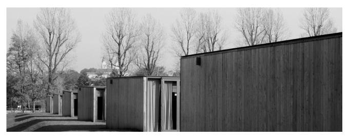
Der vom Architekten Florian Nagler konzipierte 140 Meter lange zweigeschossige Holzbau folgt sowohl dem topographischen Verlauf an der Vöttinger Straße als auch dem Verlauf des Hanges in Nord-Süd Richtung. Entlang der Vöttinger Straße gliedert er sich in eine Abfolge von würfelförmigen Baukörpern, die dem leicht abfallenden Hangverlauf folgen.
