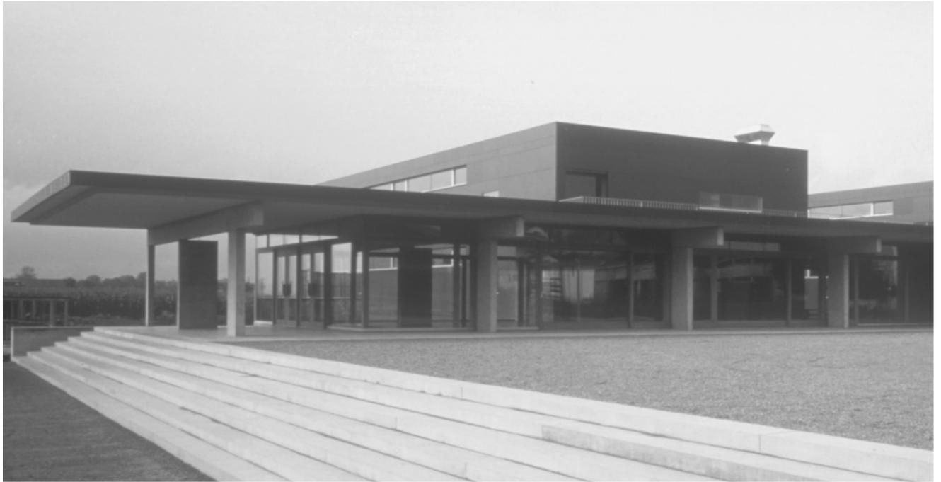
**Zum Tragwerk:** Die Gebäude der weitläufigen Schulanlage sind zum Teil in Holzbauweise ausgeführt, so etwa die Pavillons der Primarschule, der Mehrzwecksaal, der von beiden Schulen benutzt wird, aber auch die Dächer der Erschliessungstrakte. Es kamen hauptsächlich grossformatige Hohlkastenelemente zum Einsatz, die mit Dämmung gefüllt sind und deren untere Beplankung die sichtbare Deckenuntersicht bilden.
