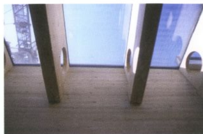
14 Anschluss Nebenträger an Kastenträger mit Verglasung © merz kaufmann partner GmbH
