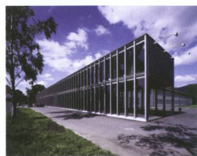
17 2003 fertig gestellter Neubau © Bruno Klomfah
