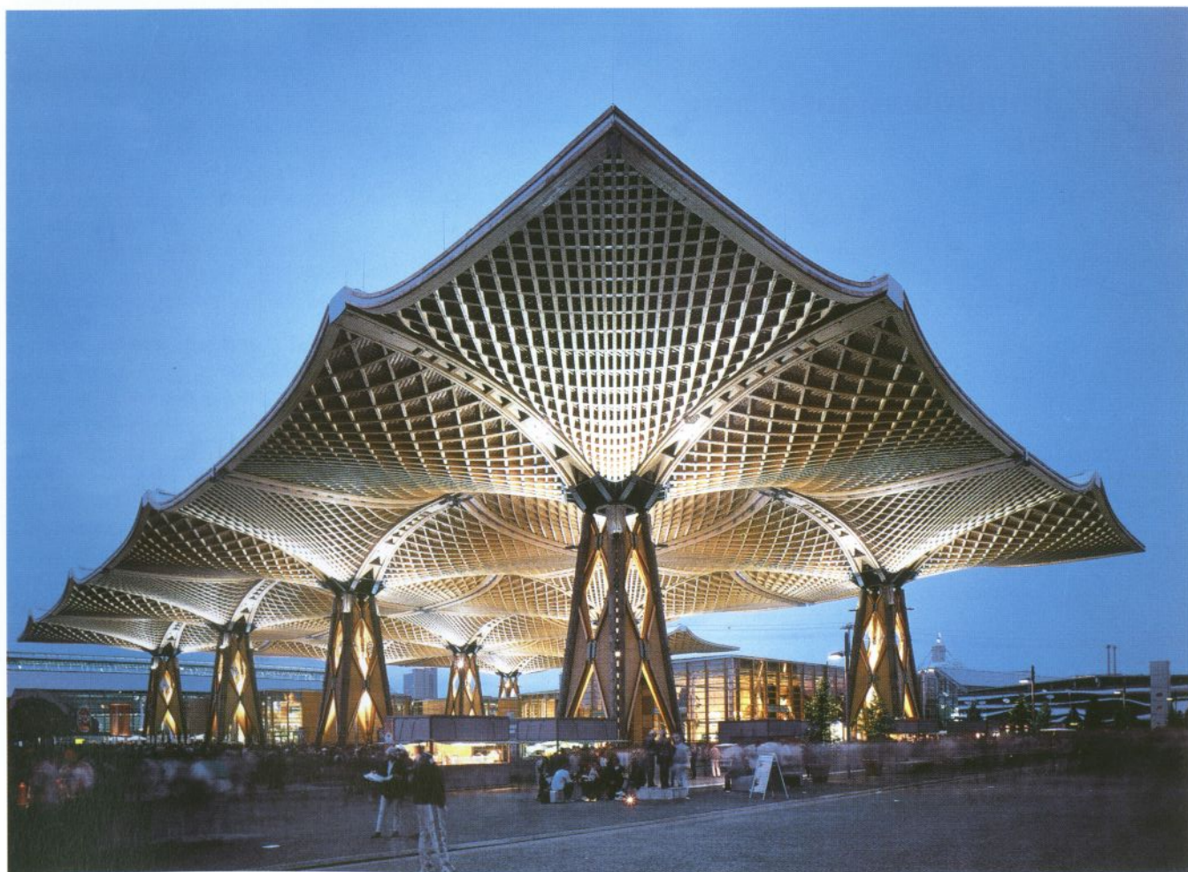
Das Expo-Dach in Hannover Bauherrschaft: Deutsche Messe AG, Hannover Architekten: Herzog & Partner, München
