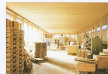
☛ A l'intérieur : bois apparent en plafond et plancher, grâce aux deux faces finies des éléments de plancher.
