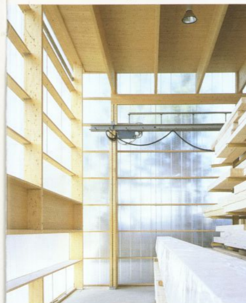
▲ En façade, des poteaux doubles soutiennent charpente et pont roulant.
