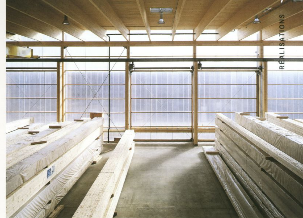
▲ En façade, des poteaux doubles soutiennent charpente et pont roulant.
