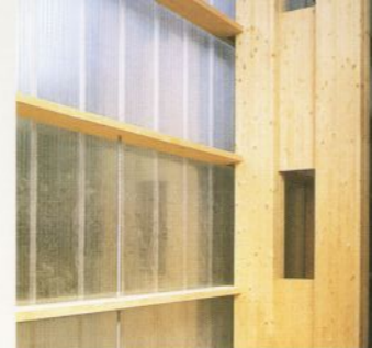
▲ En façade, des poteaux doubles soutiennent charpente et pont roulant.
