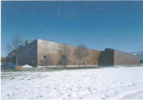
auf Kantholzpfeilen ( $100 \times 280 \text{ mm}$ ) 8 m überspannen. Das gesamte Gebäude ist durch eingespannte Betonfertigteilstützen ausgesteift, wobei in der Fassade in regelmäßigen Abständen Diagonalverstrebrungen zum Einsatz kommen.
