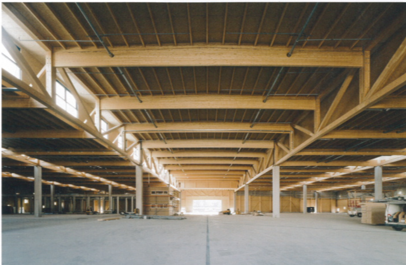
Bedingt durch die einseitige Verglasung der Dachhauben gelangt ausschließlich blendfreies Nordlicht in die Halle
