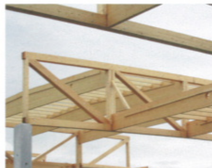
Die Holzfachwerkträger mit einer Spannweite von 27 Metern sind auf Stahlbetonstützen aufgelagert
