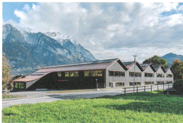
37 Das Sheddach vereint Turnhalle, Primarschule und Kindergarten.
