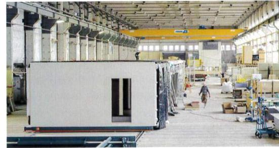
Dieser modulare Bürobau inmitten des Berliner Regierungsviertels wurde für den Deutschen Bundestag entwickelt. Alle Büros – von denen jeweils zwei zu einem Doppelbüro zusammenschaltbar sind – wurden als vorgefertigte Massivholzmodule im Werk von Kaufmann Bausysteme konzipiert.
