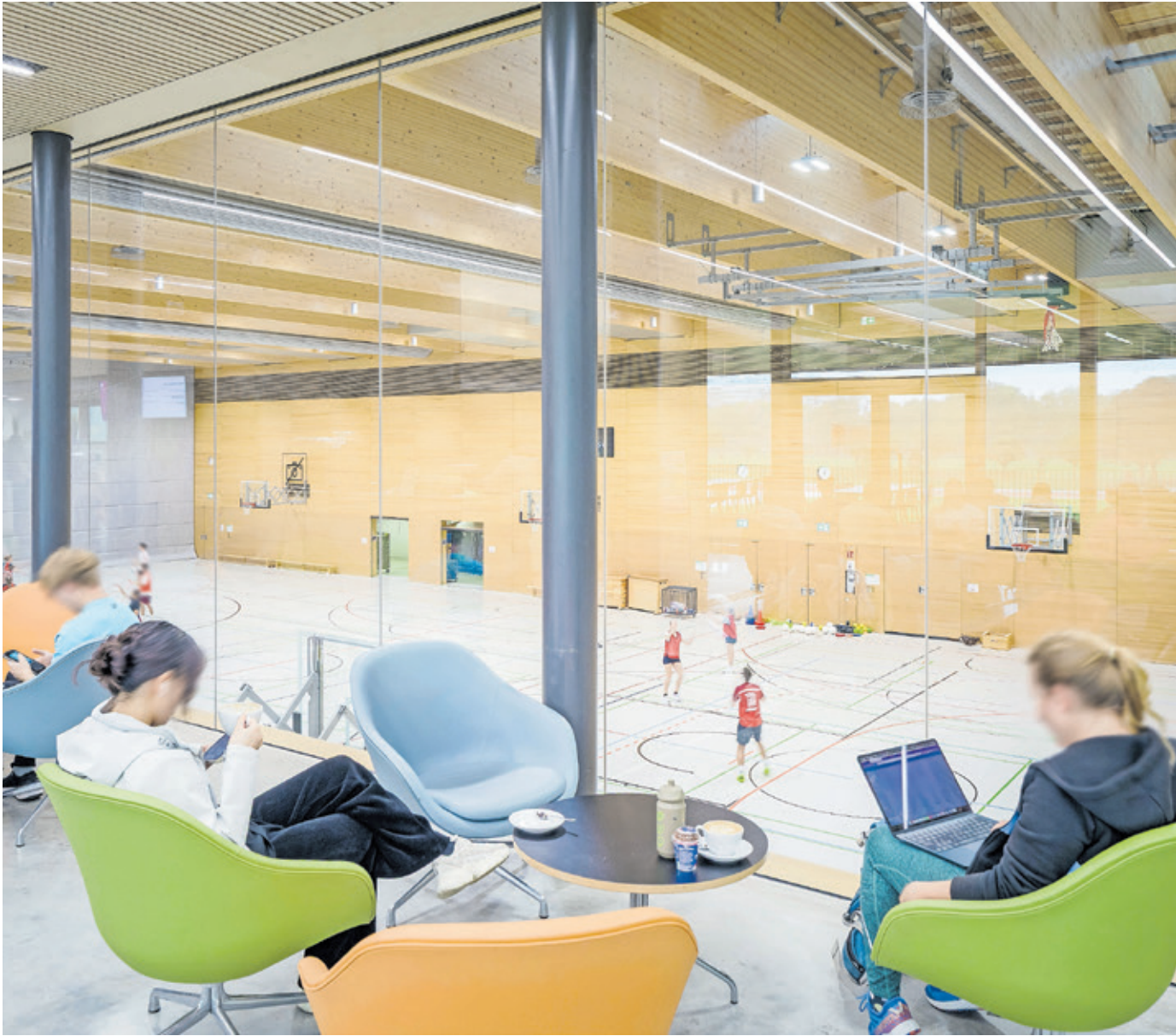
Von der Cafeteria fällt der Blick direkt in die Ballsporthalle. Sie ist wie alle anderen als reiner Holzbau konstruiert und erhält Tageslicht durch Oberlichter.
