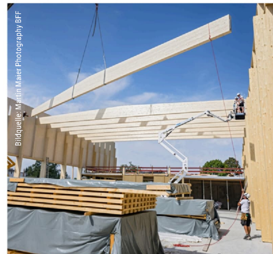
Die auf den Stützenköpfen aufgelegten Enden der Satteldach-Binder wurden zudem gegen Kippen in die Schlitz der BSP-Wand (links) eingeschoben.
