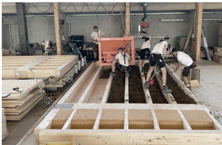
Vorfertigung der Deckenelemente bereits in der neuen Halle. Für einen guten Schallschutz wurden die Gefache mit Lehm aus dem Baugrubenaushub verfüllt.
